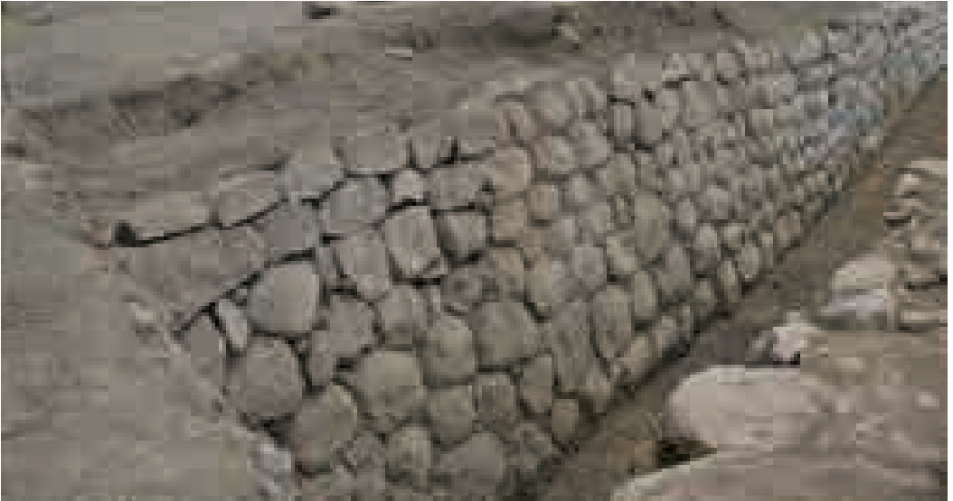
Şekil 1: II No'lu şev/istinat duvarı detay görünüşü görünüşü
